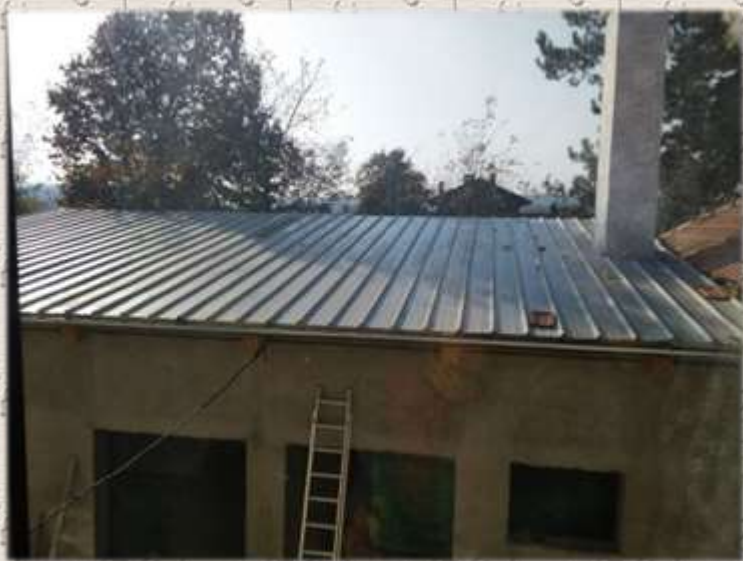
Изградња котларнице школске 2019/2020. године
